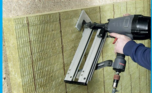
Verputzte Aussenwärmedämmung für den Holzbau
